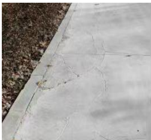
4 硬化地面开裂图 5 路牙石线型较差
